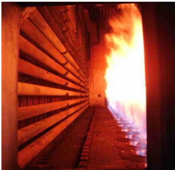
Figura 1.4: Sección de radiación de un horno de proceso. Fuente: (ESENTERM.ca PDVSA. 2008)
