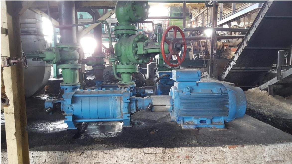
**Figura 2.2. Conjunto motor bomba del sistema de agua de alimentar calderas del Central Ciudad Caracas.**
