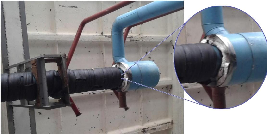
Figura 3.2 Tubería incorrectamente insulada. Fuente: Elaboración propia.
