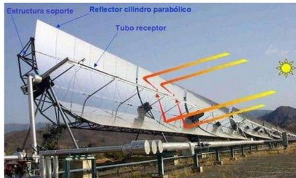
Fig. 14 Captador cilindro parabólico.
