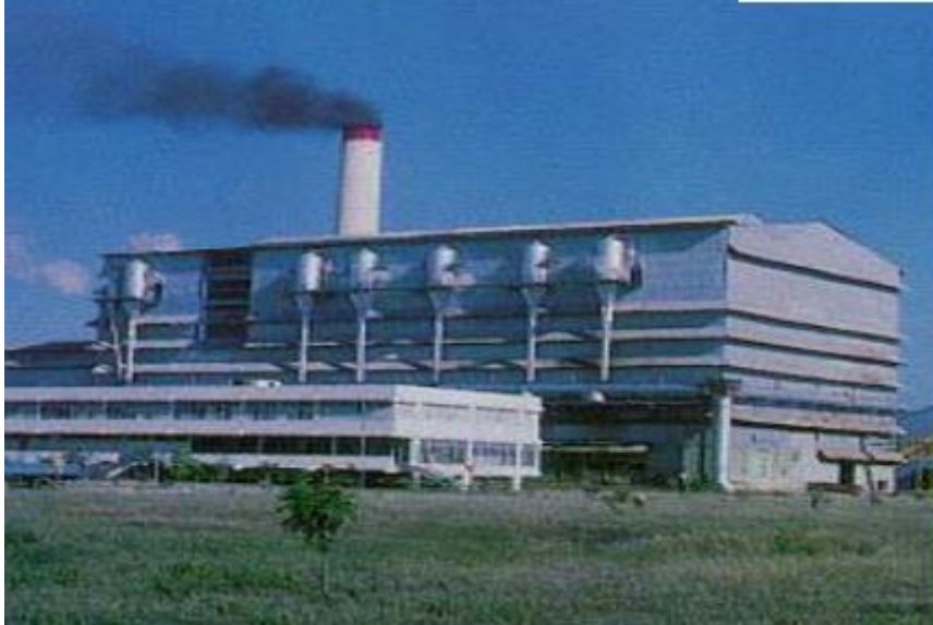
Figura 1.1 Vista desde fuera de un central azucarero. Fuente: (Amaya, 2014)
