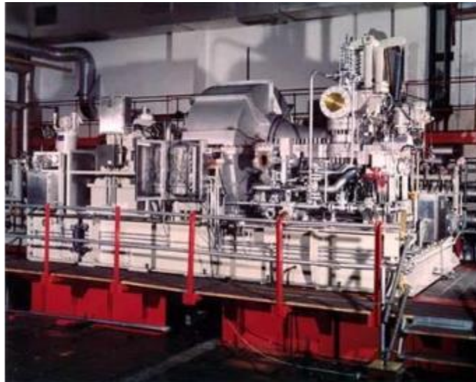
Figura 1.7 Turbogenerador de contrapresión. Fuente: (Victoria, 2009)
