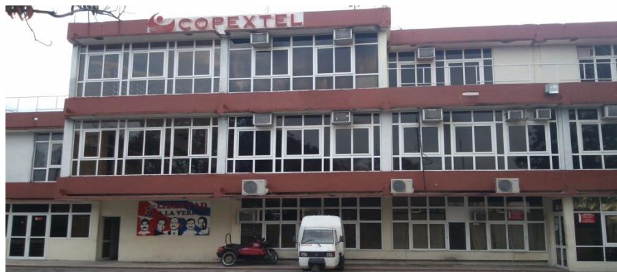
Fig. III.2 Edificio administrativo de Copextel Cienfuegos.
