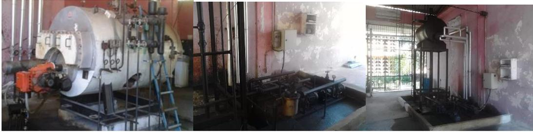
**Figura II.2.** Caldera pirotubular y sala de caldera
