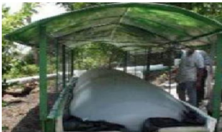
Imagen 2.1: Digestor caso de estudio uno
