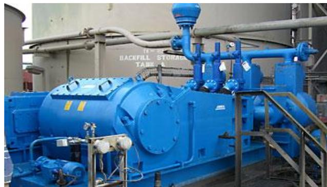
Figura 1.10 Rango de operación: hasta 600 m³/h (2640 GPM) y 25,0 MPa (3625 psi). Fuente: («Bombas hidráulicas de membranas HMT», 2012)
