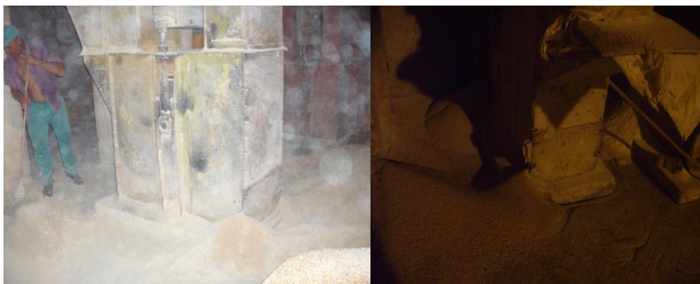
Figura 2.9 Pie de Elevadores en el sótano
