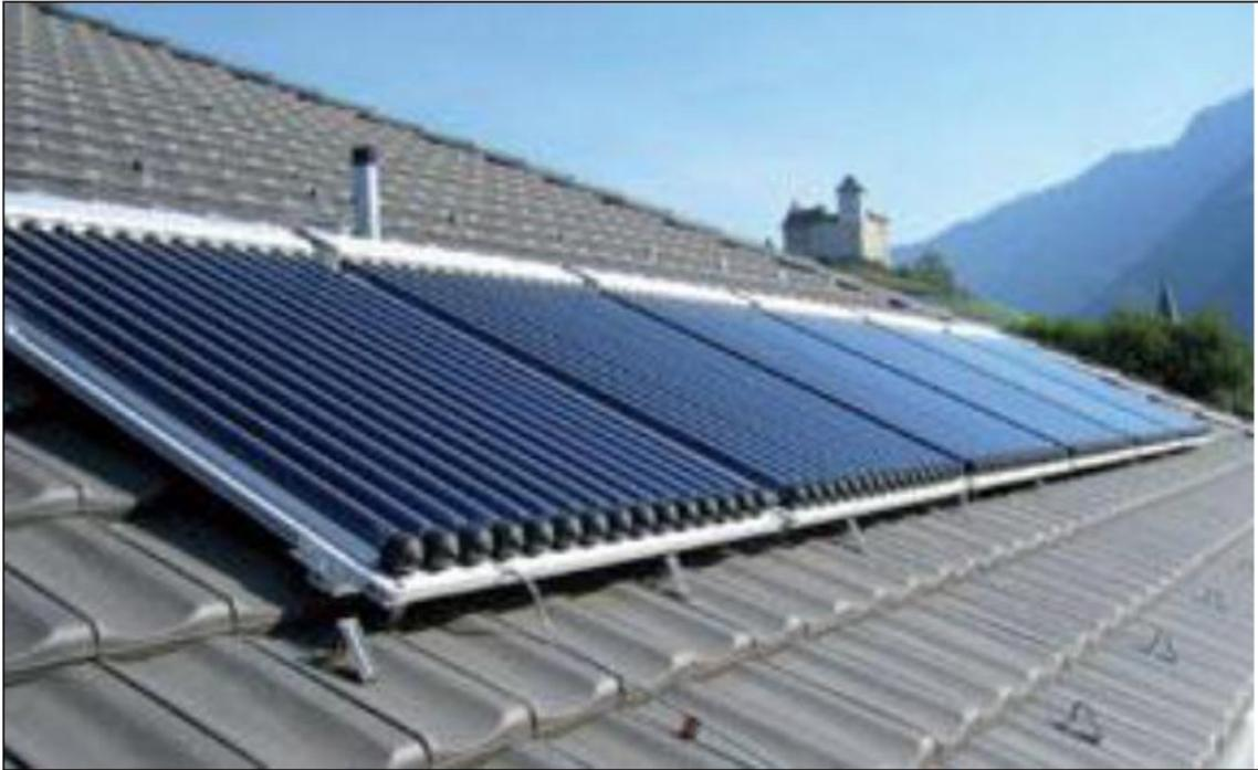
**Figura 1. 6. Colectores solares de tubos al vacío.**
