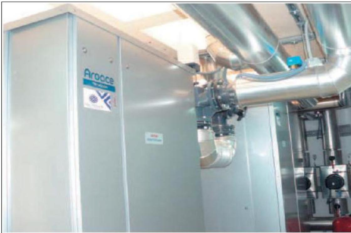
Figura 3. 3. Máquina de absorción de simple efecto YAZAKI SC 30.
