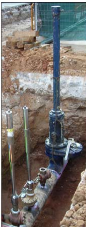
Fig.1.6. Diferentes tipos de Hot Tap en operación (Tbl-182, 242 y el 302 th).
