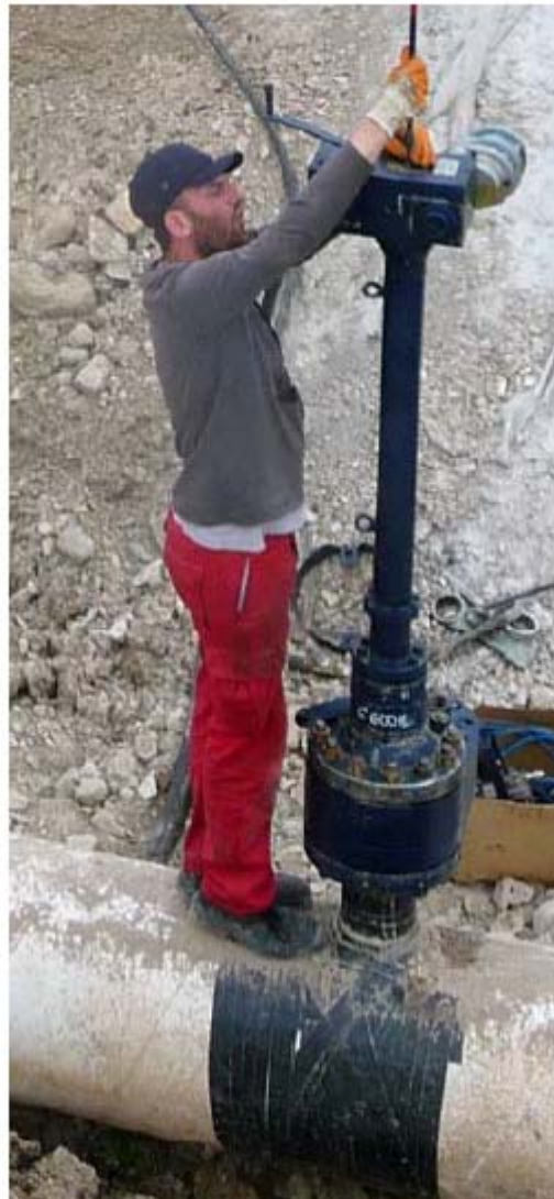
Fig.1.4 Hot Tap tbl-0322 realizando una perforación de 6 pulgadas.
