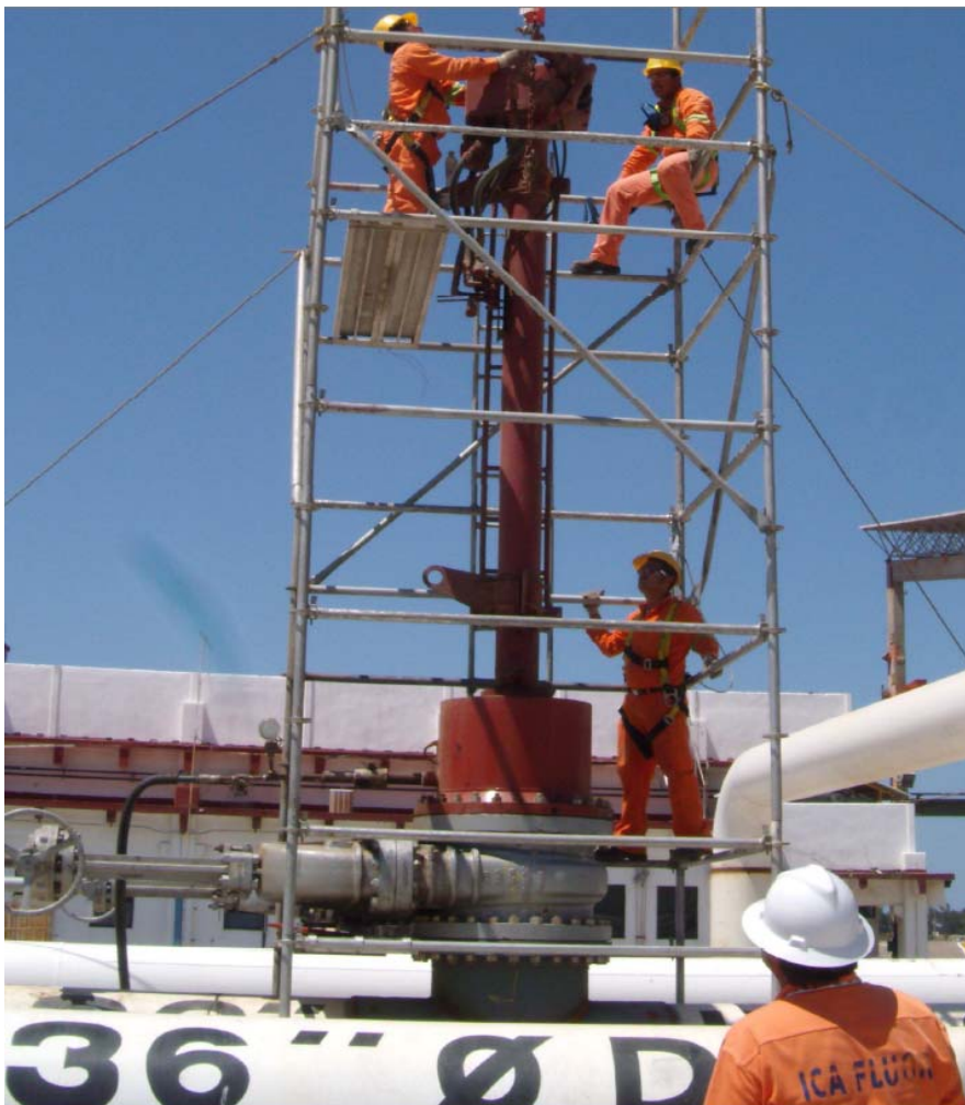
Fig. 1.3 Hot Tap realizando una perforación de diámetro 36 pulg.
