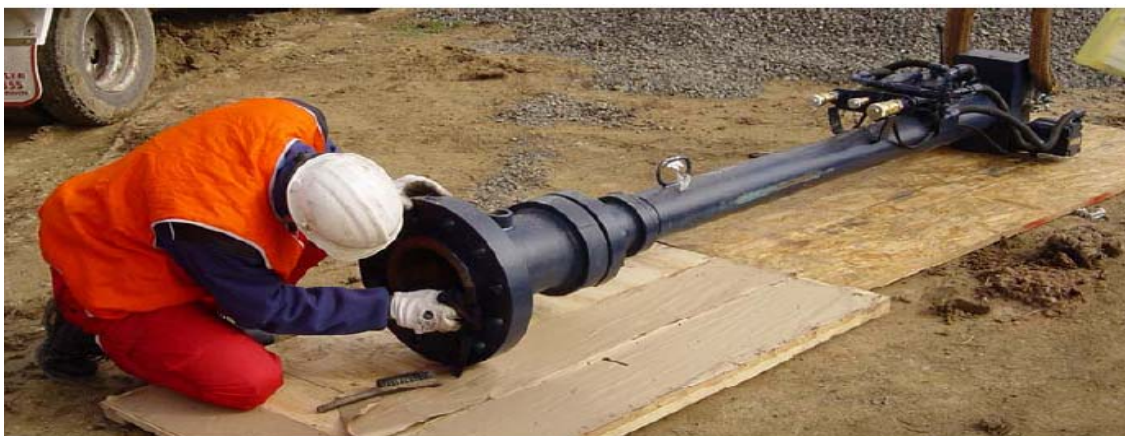
Fig.1.1 Hot Tap TBL-0664 preparándolo para realizar una perforación de diámetro de 12 pulg.
