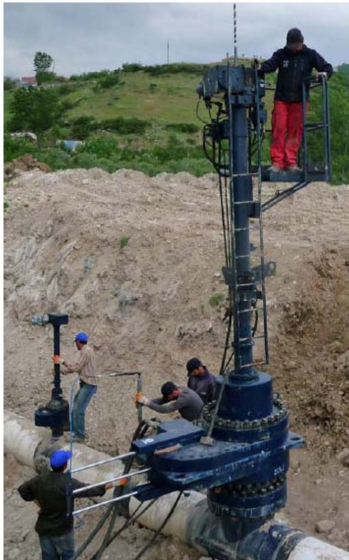
Fig.1.5. Hot Tap Tbl-1106 en una línea de 24 pulg.
