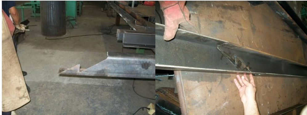
Figura 1.7 Corte de preparación para el empate del bastidor
