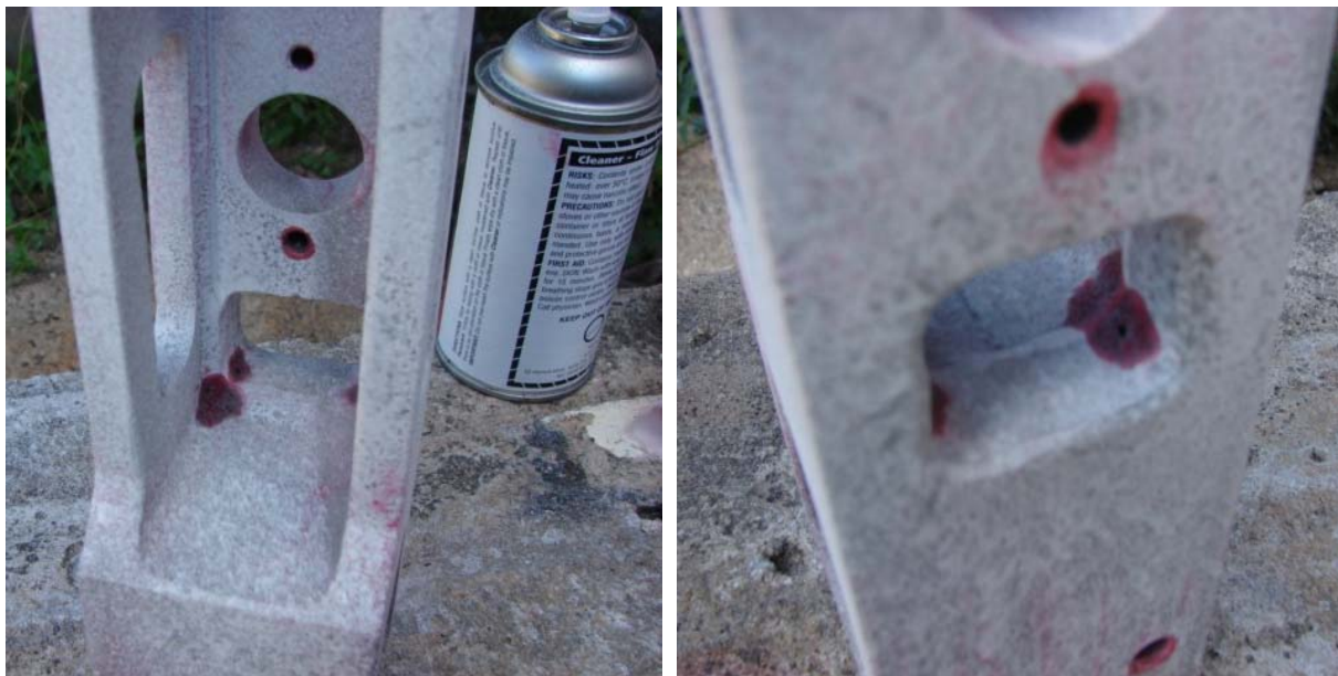
Foto 5. Prueba de líquido penetrante a la barra superior.
