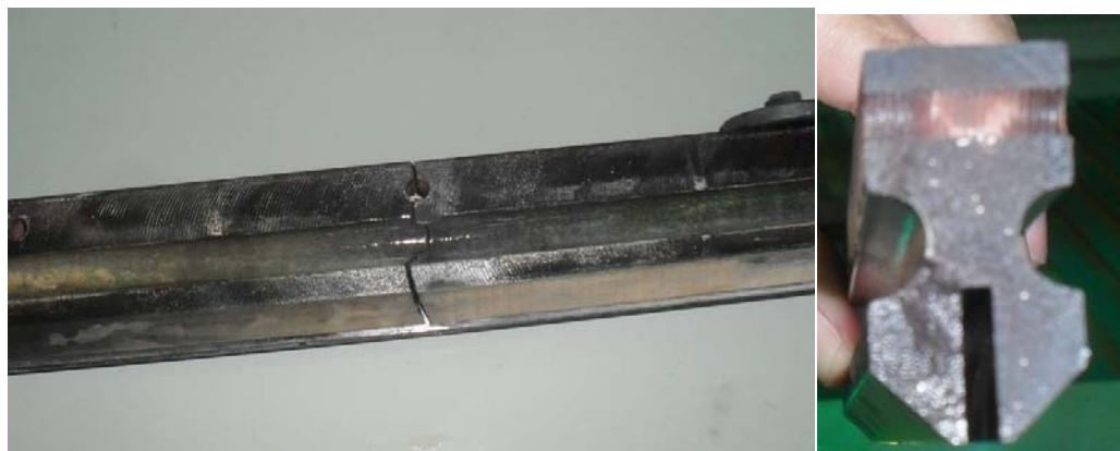
Fig. 1.23. Grieta en la barra inferior.
