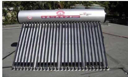
**Figura 1.3 Colector de tubos al vacío**
