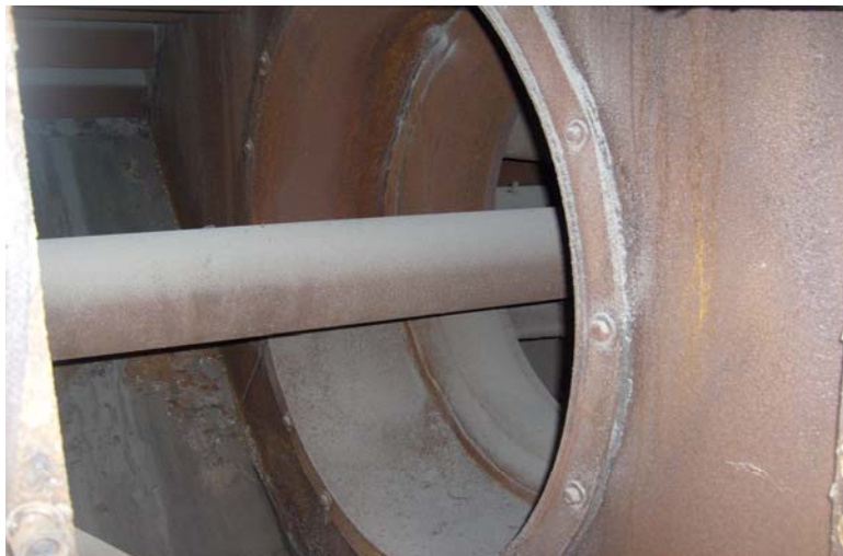
Foto 4: Eje y ojo de succión del ventilador.
