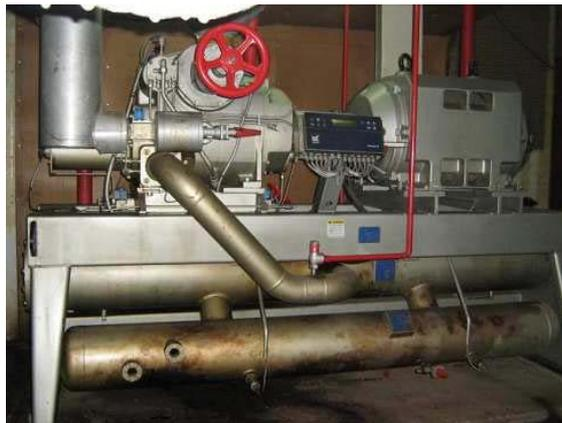
Fig. 3.10. Vista frontal de la unidad de compresores.
