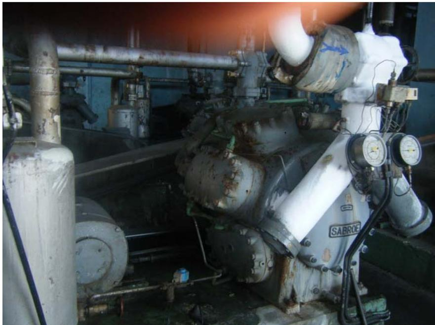
Fig. 3.2 Vista lateral compresor recíprocante de la empresa Epicien.
