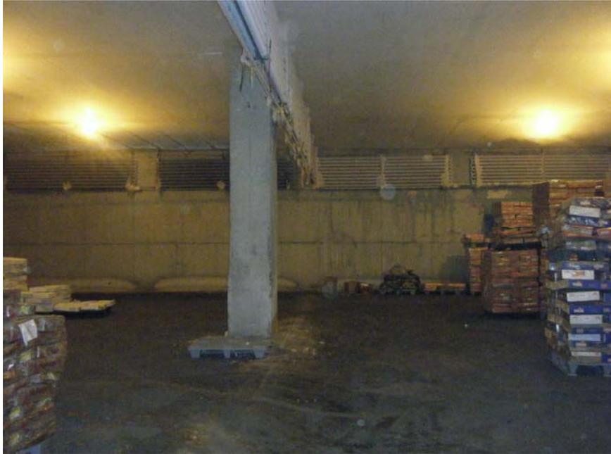
Fig. 3.4. Interior de la cámara frigorífica mostrando la colocación de las baterías.
