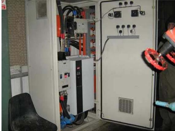
Fig. 3.8. Pizarra de control eléctrico y automática.
