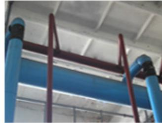
Anexo IV Empalme de tuberías de succión y descarga de los compresores.
