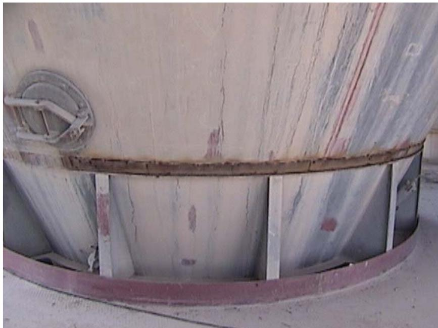
**Fig. 1.8** Vista de las grietas reparadas y reforzadas con una planchuela circunferencial de refuerzo colocada a modo de cubrejuntas.
