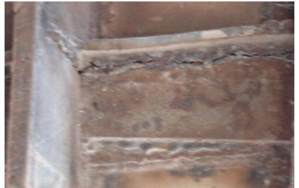
**Fig. 1.13 Refuerzos circunferenciales agrietados nuevamente después de reparados los cordones por el Efecto de Borde aun presente**
