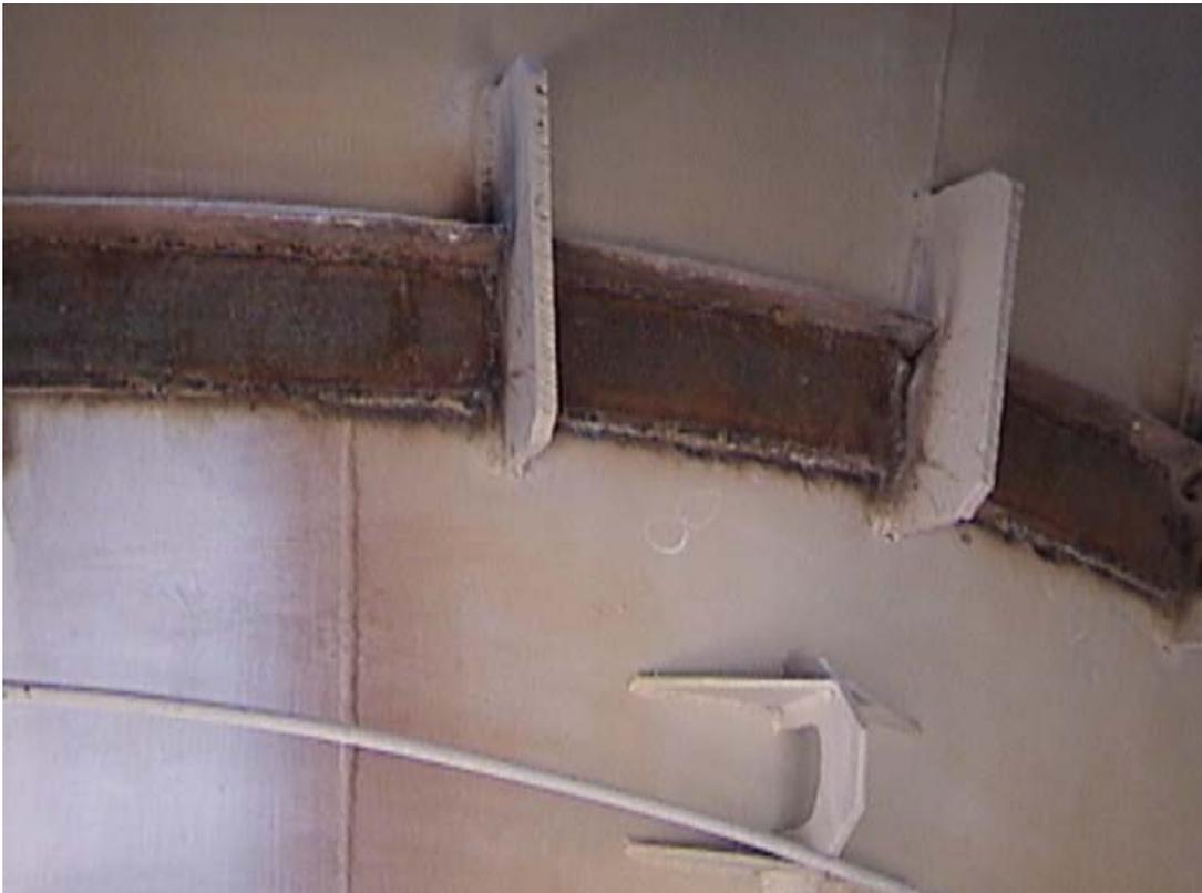
**Fig. 1.9 Refuerzos colocados en las grietas de soldadura del cono del ciclón.**
