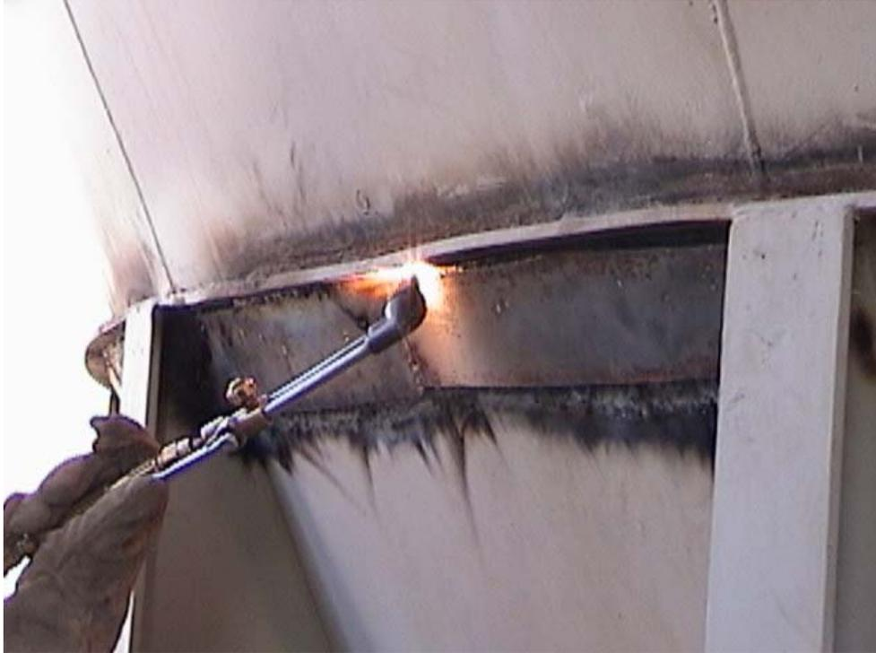
**Fig. 1.7** Reparación de las grietas de soldadura del cono del ciclón.
