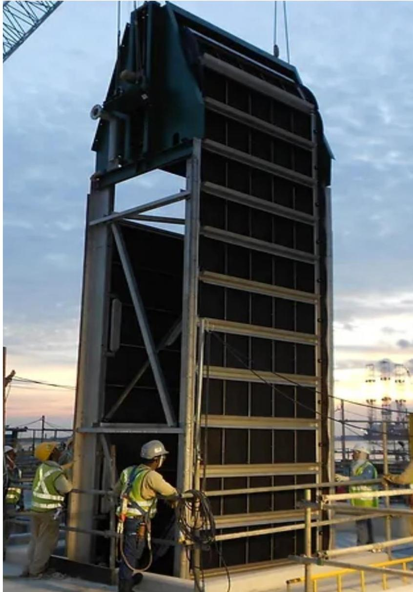
**Figura 1.1:** Filtro tipo pantalla giratoria
