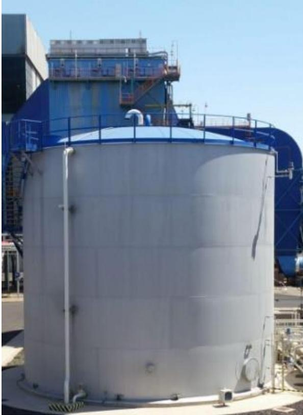
Figura 1: Depósito cilíndrico vertical, fondo plano y techo cilíndrico
