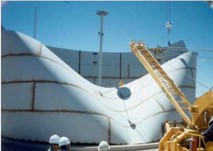
Figura 6: Fallo por falta de soldadura
