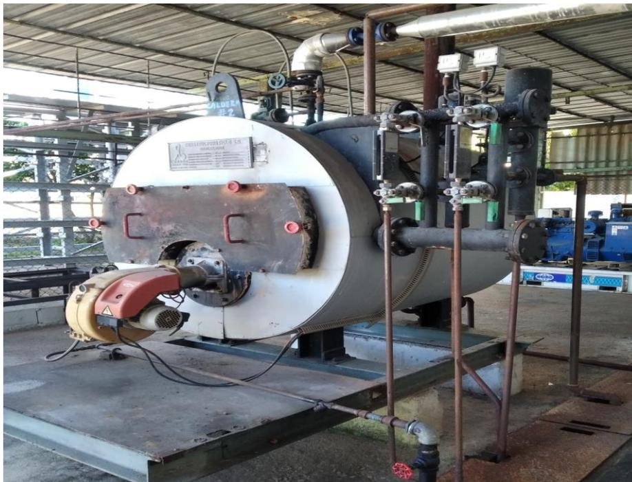
**Fig. 2.5** Caldera pirotubular modelo Lambda 250.
