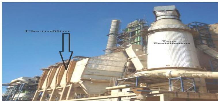
Fig. 2.11 Electrofiltro y Torre Estabilizadora. Fuente: (Cementos Cienfuegos S.A, 2010)
