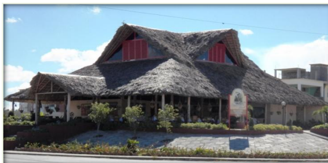
Figura 1: Fachada del restaurante. Fuente: Elaboración propia.
