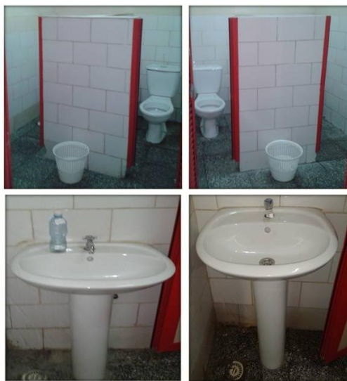
Figura 15: Servicios sanitarios públicos. Fuente: Elaboración propia
