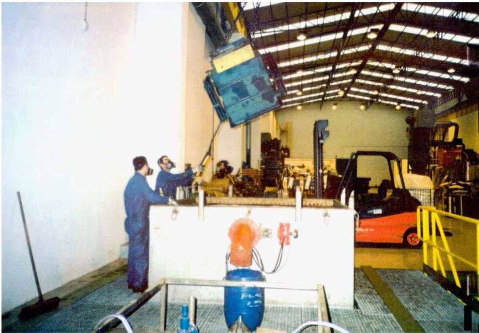
**Figura 9.** Trabajadores con vestimenta de protección mientras trabajan con un transformador de PCB. Fuente: PNUMA (Primera Edición)
