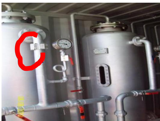
Figura 3.18: Magnetizadores DIMAG en sistema de agua tecnológica de la tecnología Hyundai.
