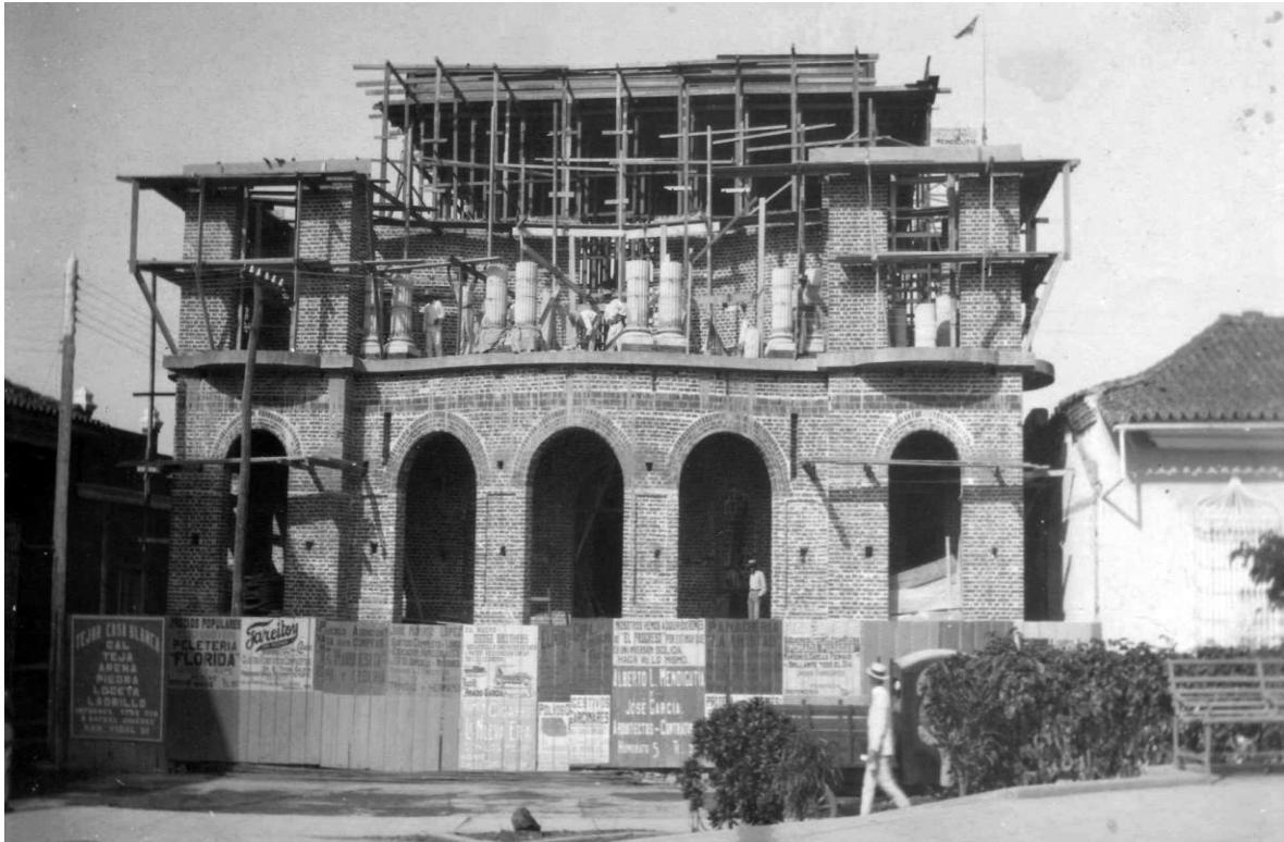
(Imagen 4) Construcción del edificio de la sociedad El Progreso
