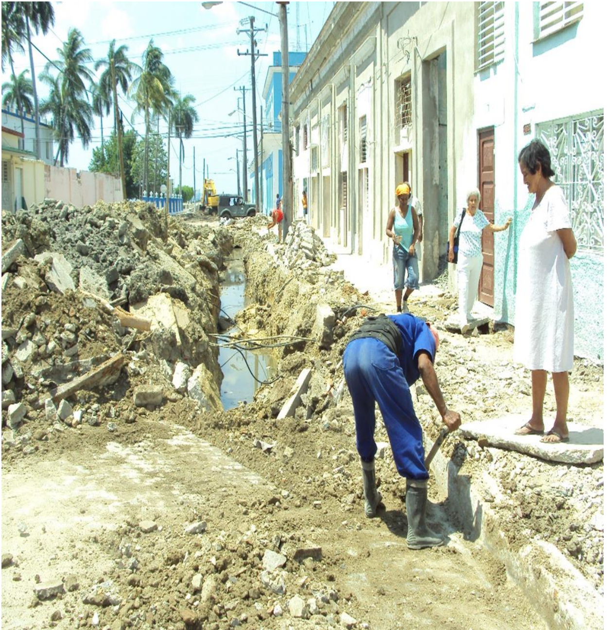
Proceso de rehabilitación de la calle Santa Isabel
