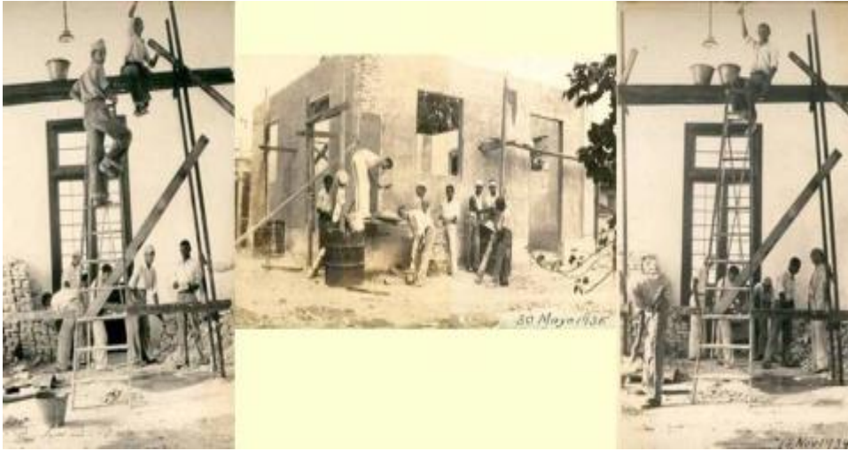
Taller de albañilería
