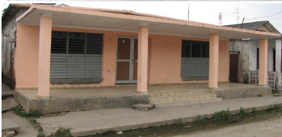
Después de reparado
