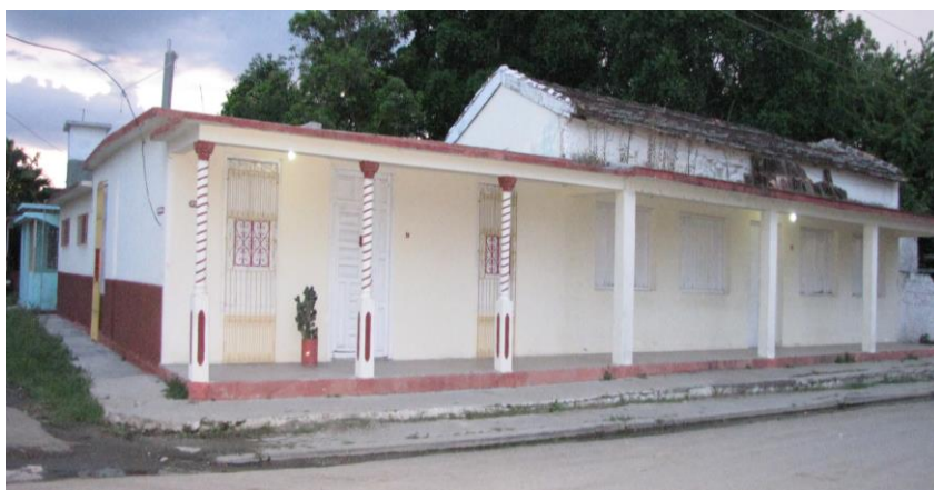
Después de reparada
