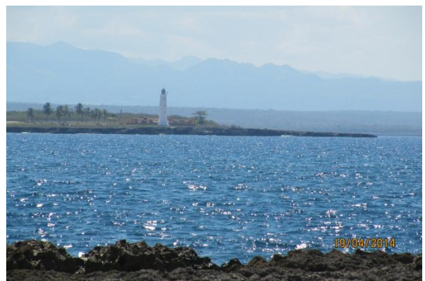
Vista del faro "Villanueva" desde Punta Sabanilla
