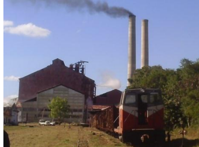
Casa generadora eléctrica y Locomotora de caña.
