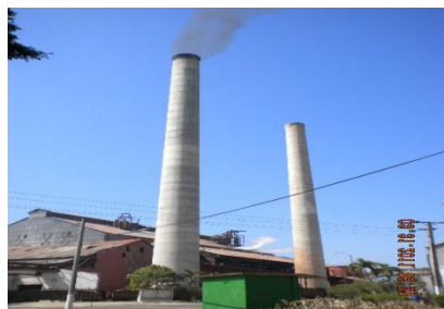
Vista de las torres del central.
