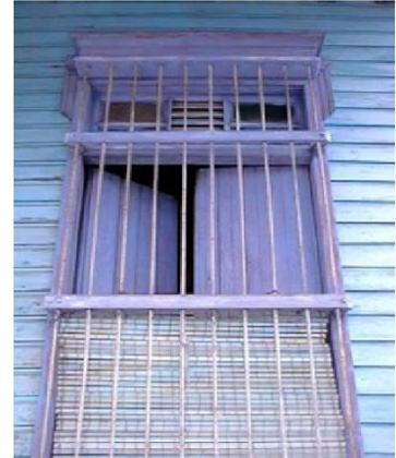
Adicionalmente el marco volado se proveía de patas o tacos torneados que permitían el descanso del elemento sobre el piso. Coronando el conjunto se colocaba un guardapolvo semejando una cornisa de aspecto clásico, elaborado con tablas de diversa sección según las molduras diseñadas.
