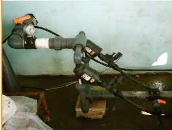
Figura 10. Cabezal de riego.
