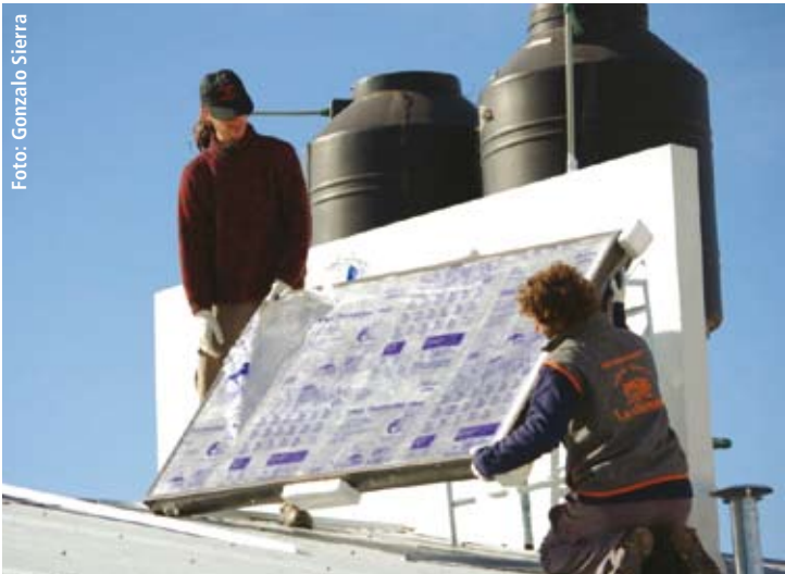
Técnicos de Vademarco ajustan el colector sobre una de las casas del barrio La Perla.
